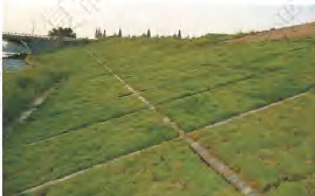
图 3-6生态混凝土护坡示例图
