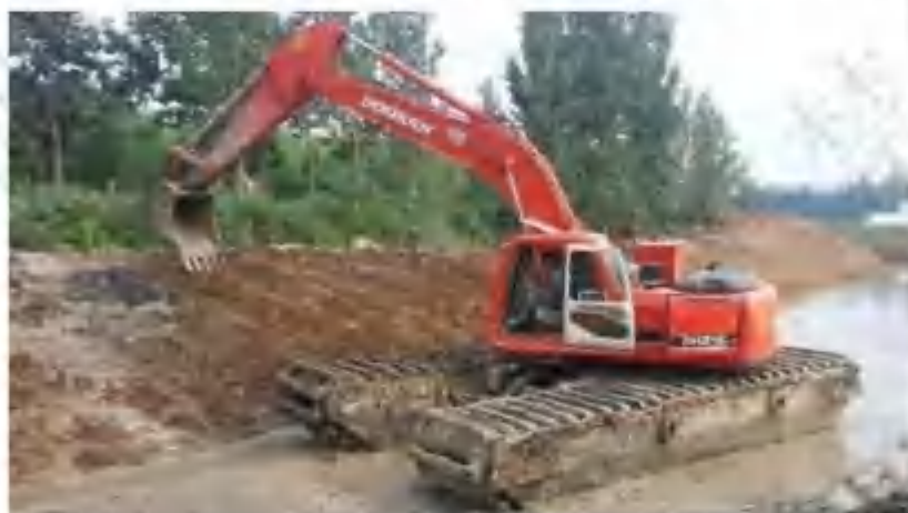
图 2-13 河底疏挖及边坡整形示意图
