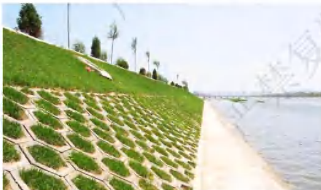
图 3-8生态绿化砌块护坡示例图
