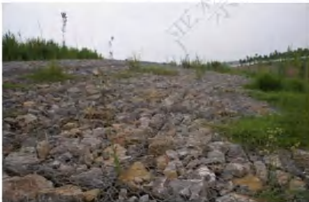
图 3-7 生态石笼护坡示例图
